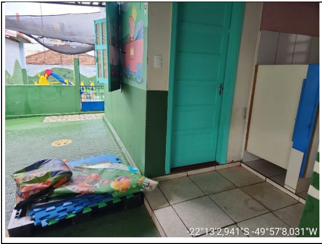
Foto 9 – Vista da entrada de sala de aula.
