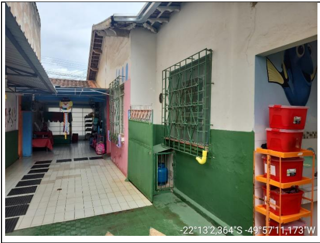
Foto 7 - Vista geral da edificação.
