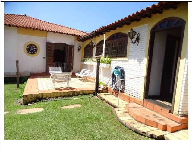
Foto 17 - Vista da área externa do imóvel avaliando.
