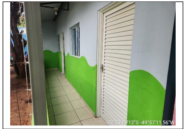
Foto 6 – Vista das entradas das salas de aula.
