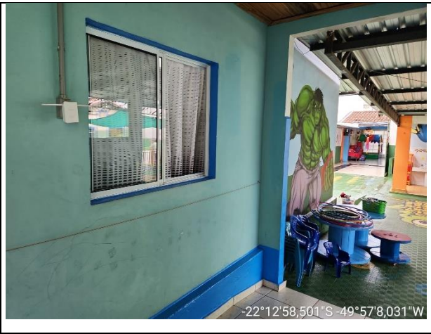
Foto 10 – Vista geral da edificação.
