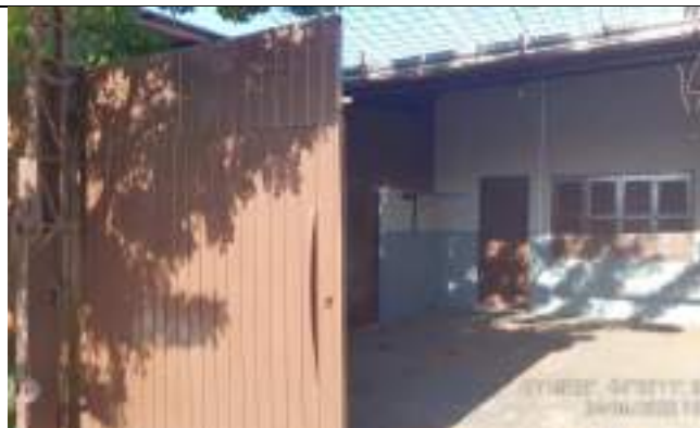
Vista interna ao muro frontal – frente do imóvel
