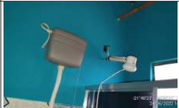
Banheiro privativo 01 – azulejo em ½ parede
