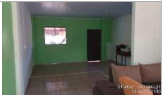
Copa – forro em pvc
