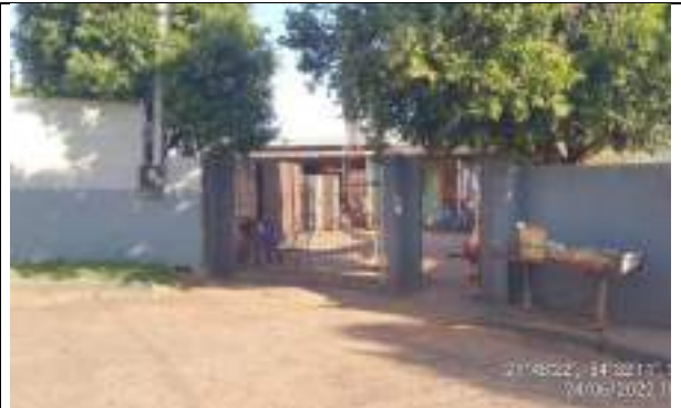
Fachada do imóvel – entrada lateral
