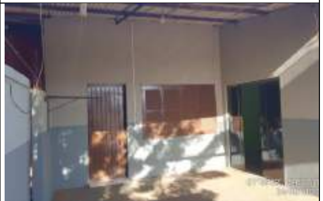
Vista interna ao muro – entrada para a sala de estar e a cozinha
