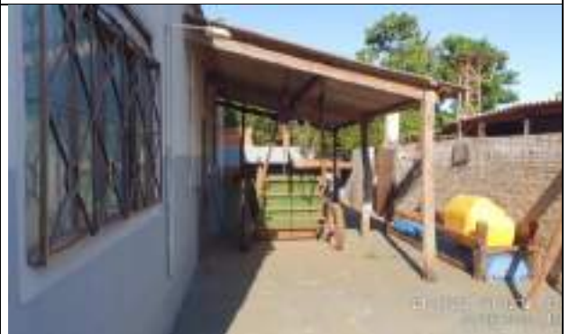
Vista dos fundos
