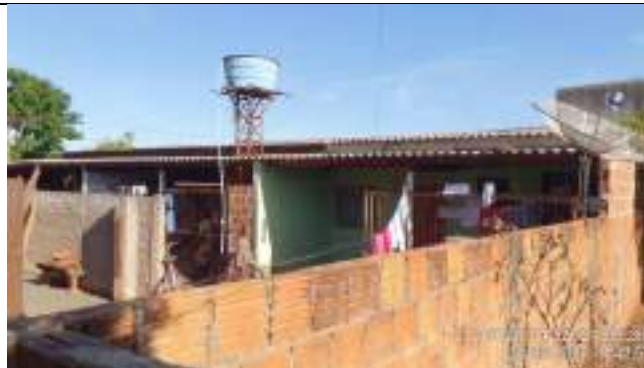
Construção existente no terreno
