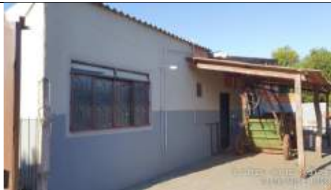
Vista dos fundos – varanda com área de serviço
