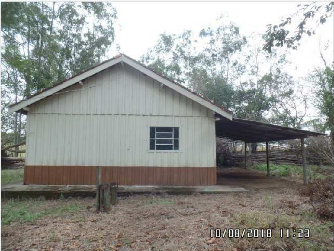
Figura 07: Casa para funcionário.
